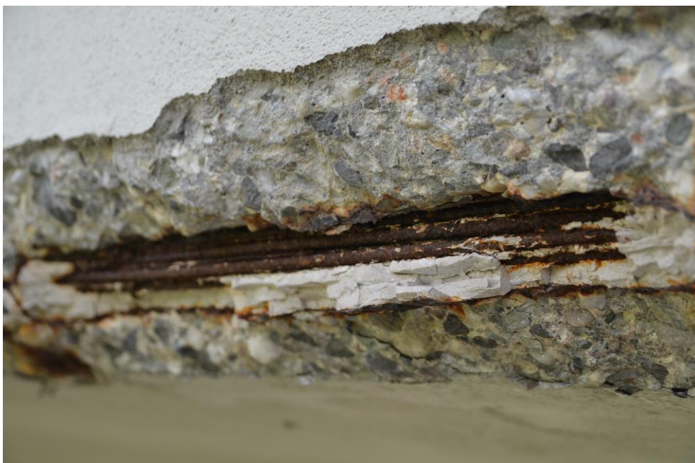
Obr.F32-104 Sonda S 12. Detail levé části odtrhu, obr. F32-103.
