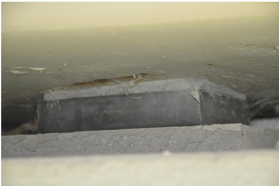
Obr.F32-47 Úložný práh (UP) 2. podpěry, pelhřimovský líc. Ložisko pod 2. nosníkem 2. pole. Pohled doprava (po vodě) a proti směru staničení (k Jihlavě),
