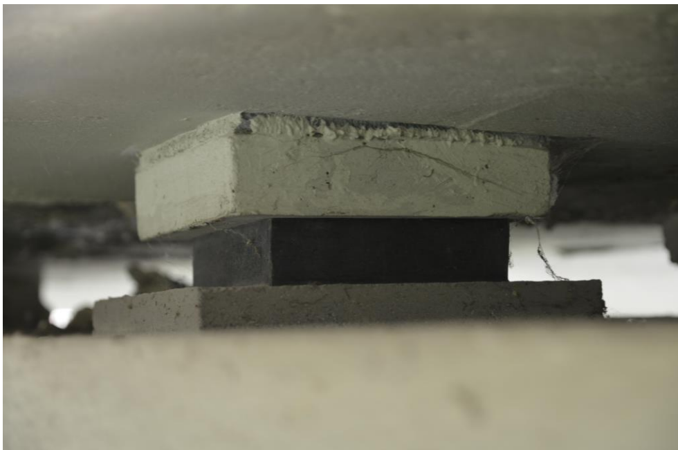
Obr.F32-52 Úložný práh (UP) 2. podpěry, pelhřimovský líc. Ložisko pod 5. nosníkem 2. pole. Pohled doprava (po vodě), proti směru staničení (k Jihlavě) a vzhůru,
