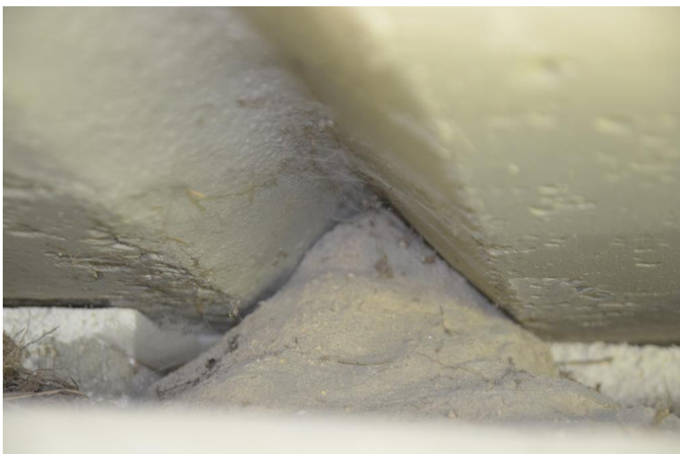
Obr.F32-48 Úložný práh (UP) 2. podpěry, pelhřimovský líc. Podélná spára mezi 2. (vpravo a 3. nosníkem nad UP. Pohled proti směru staničení (k Jihlavě),
