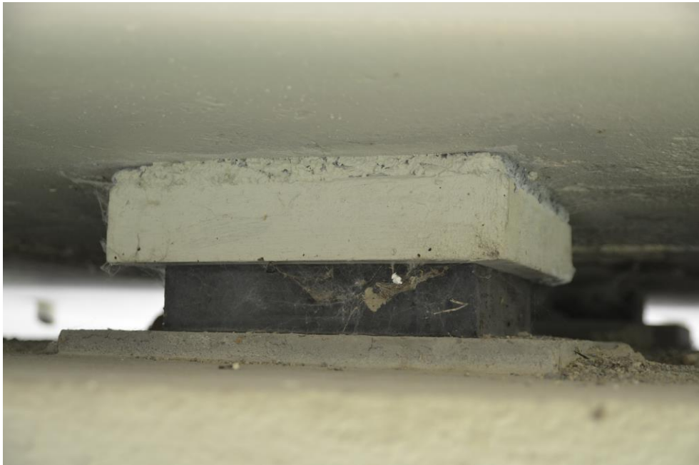
Obr.F32-51 Úložný práh (UP) 2. podpěry, pelhřimovský líc. Ložisko pod 4. nosníkem 2. pole. Pohled doprava (po vodě), proti směru staničení (k Jihlavě) a vzhůru,
