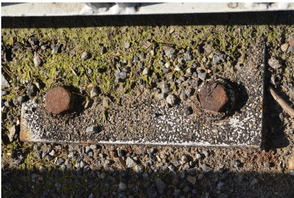
Obr.F32-140 Příklad kotevní desky zábradelního svodidla. Pohled přímo dolů,
