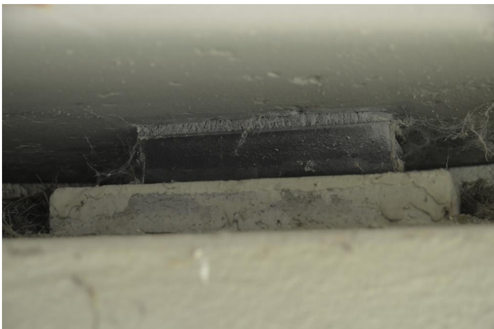
Obr.F32-50 Úložný práh (UP) 2. podpěry, pelhřimovský líc. Ložisko pod 3. nosníkem 2. pole. Pohled proti směru staničení (k Jihlavě) a vzhůru, - ložisko v nízké spáře (má jen malé horní podlití) je bez závad.
