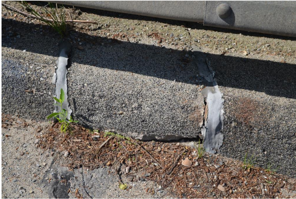
Obr.F32-125 Detail vnitřní části mostního závěru (obruba pravého odrazného proužku) nad 6. podpěrrou, pelhřimovskou opěrou, viz obr. F32-124. Pohled zleva doprava (po vodě) a dolů,
