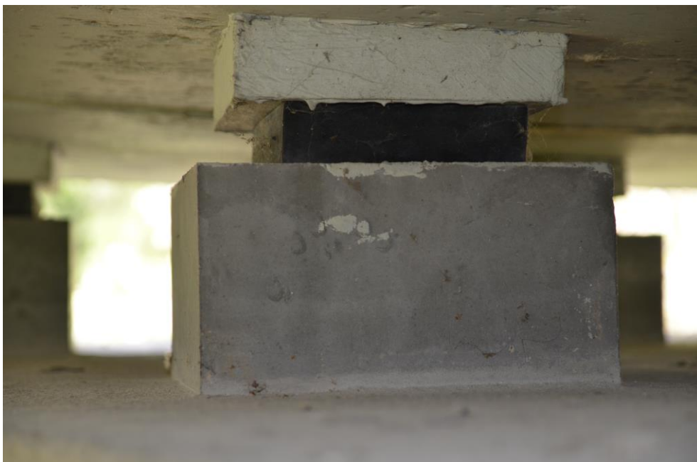
Obr.F32-60 Úložný práh (UP) 2. podpěry, pelhřimovský líc. Ložisko pod 11. nosníkem 2. pole. Pohled doprava (po vodě), proti směru staničení (k Jihlavě) a vzhůru,
