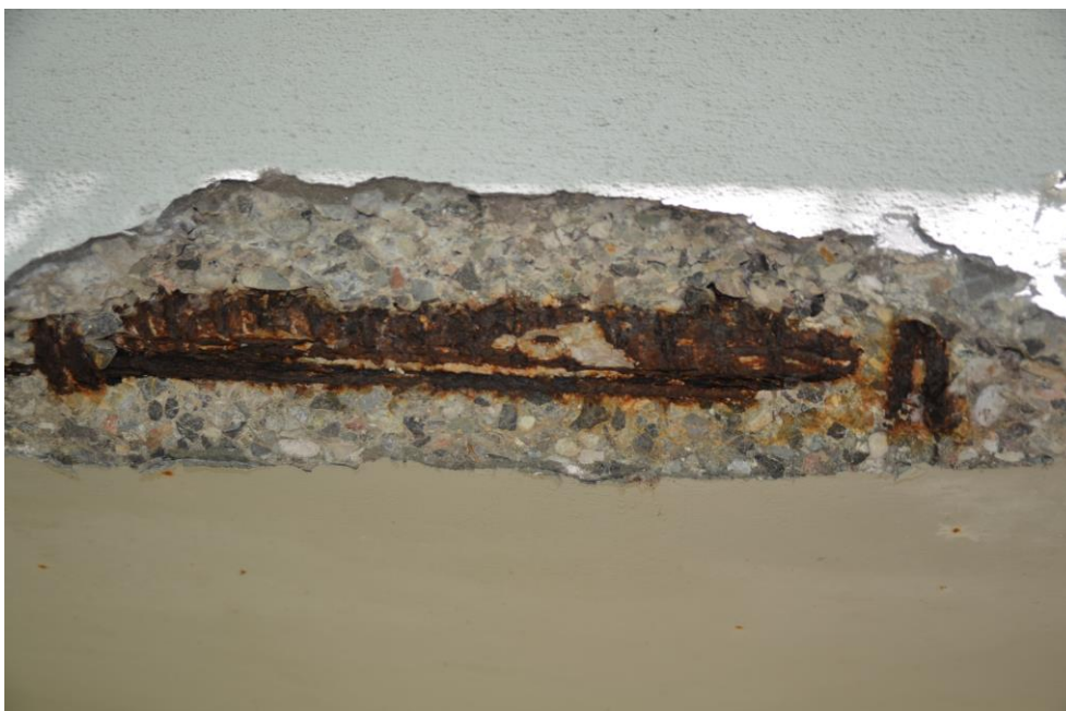
Obr.F32-112 Sonda S 15. Vnější dolní hrana 1.nosníku před polovinou 5. pole . Pohled zprava doleva (proti vodě) a ve směru staničení (k Pelhřimovu),
