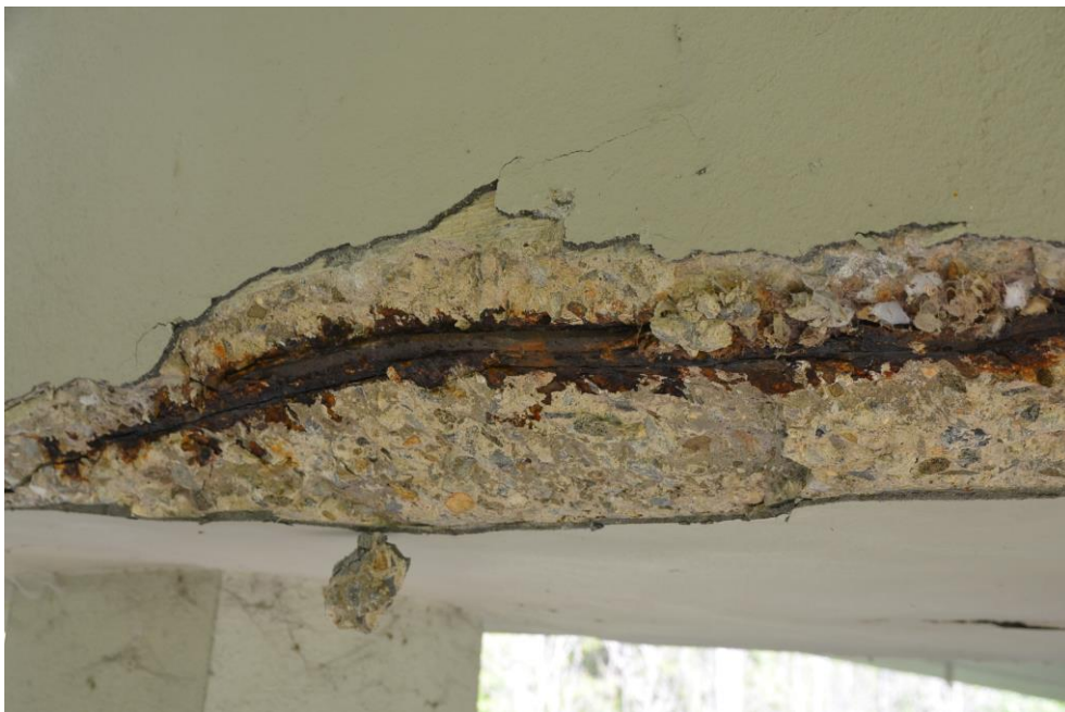
Obr.F32-55 Úložný práh (UP) 2. podpěry, pelhřimovský líc. Odtržení krycích vrstev nad korodující výztuží mezi 3. a 4. sloupem. Pohled proti směru staničení (k Jihlavě) a vzhůru,
