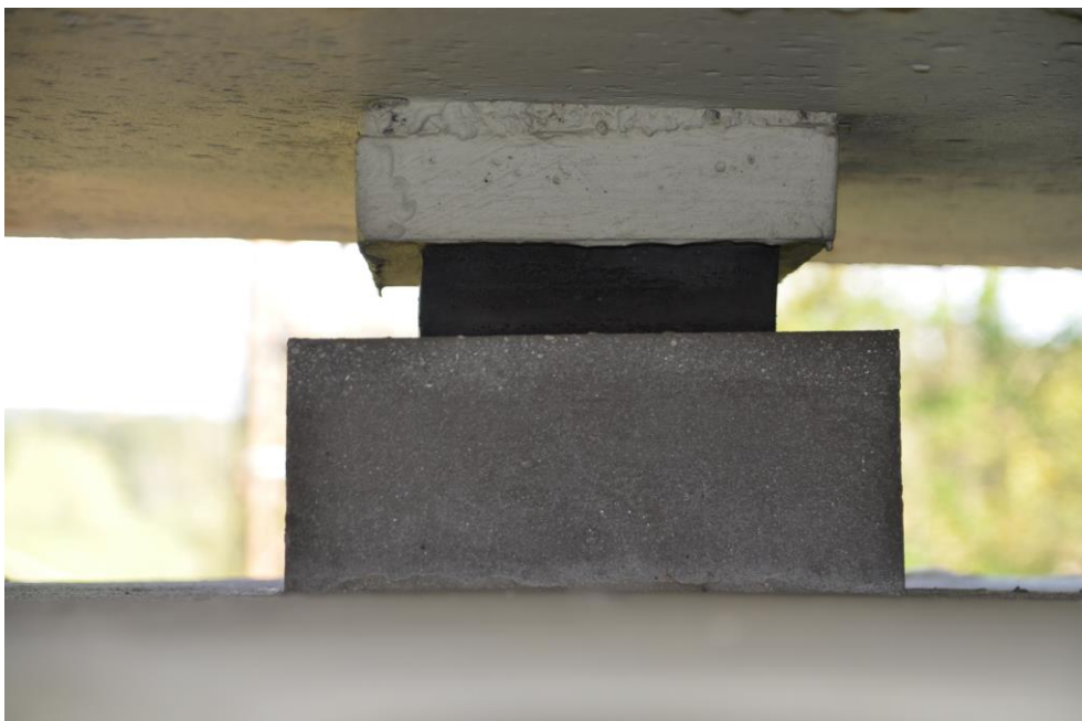
Obr.F32-81 Úložný práh (UP) 5. podpěry, pelhřimovský líc. Ložisko pod 12. nosníkem 5. pole. Pohled doprava (po vodě), proti směru staničení (k Jihlavě) a vzhůru,
