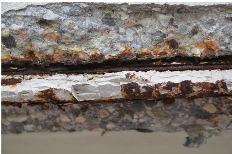
Obr.F32-108 Sonda S 13. Detail pravé části odtrhu, obr. F32-106, - v této části je opadaná jak zkorodovaná část trubky SANDRIK, tak i část injektážní malty. V horní části je již možné vidět korodované prameny předpjatého kabelu. Jsou oslabeny asi o 30 %.
