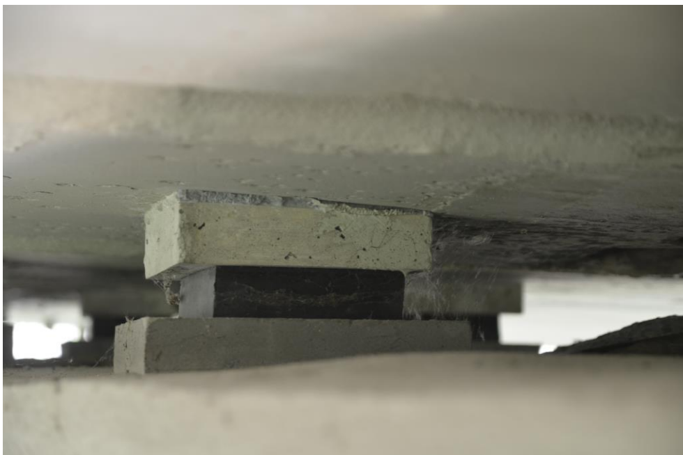
Obr.F32-68 Úložný práh (UP) 5. podpěry, pelhřimovský líc. Ložisko pod 2. nosníkem 5. pole. Pohled doprava (po vodě), proti směru staničení (k Jihlavě) a vzhůru,
