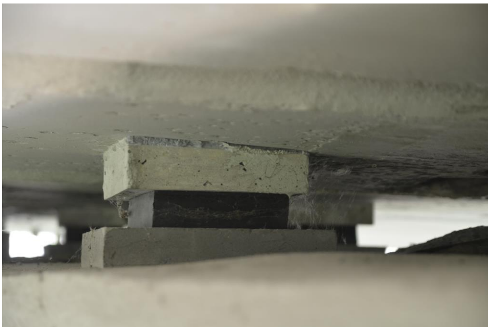
Obr.F32-54 Úložný práh (UP) 2. podpěry, pelhřimovský líc. Ložisko pod 7. nosníkem 2. pole. Pohled doprava (po vodě), proti směru staničení (k Jihlavě) a vzhůru,
