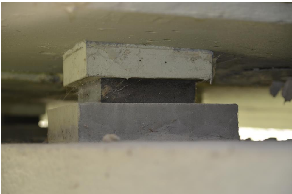
Obr.F32-56 Úložný práh (UP) 2. podpěry, pelhřimovský líc. Ložisko pod 8. nosníkem 2. pole. Pohled doprava (po vodě), proti směru staničení (k Jihlavě) a vzhůru,
