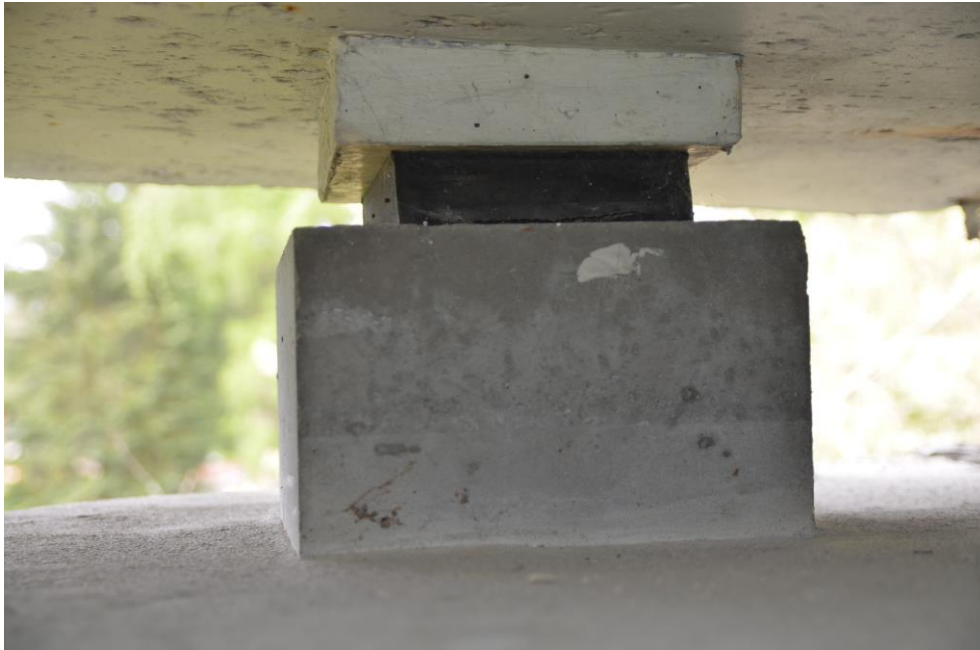
Obr.F32-61 Úložný práh (UP) 2. podpěry, pelhřimovský líc. Ložisko pod 10. nosníkem 2. pole. Pohled doprava (po vodě), proti směru staničení (k Jihlavě) a vzhůru,
