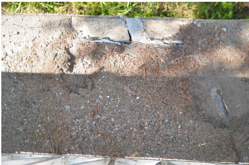
Obr.F32-126 Detail vnější části mostního závěru ( pravá římsa nad 6. podpěrrou, pelhřimovskou opěrou, viz obr. F32-132. Pohled zleva doprava (po vodě) a dolů,
