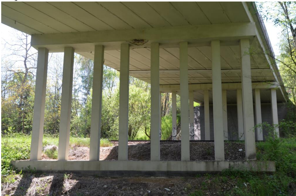
Obr.F32-24 Čtvrtá podpěra. Pohled ve směru staničení, k Pelhřimovu, - vlevo je směr proti vodě, vpravo po vodě, - do základového pásu je kotveno 8 prefabrikovaných sloupů půdorysu 450x450 mm, - řada z nich je v patě oslabena korozí výztuže po ztrátě pasivačních vlastností betonu krycích vrstev a jejich opadání či uvolnění, - sloupy jsou v patách vyztuženy při jihlavském a pelhřimovském povrchu pěti vložkami betonářské výztuže \varnothing přibližně 20 mm, které zde nejsou nijak výrazně oslabené.
