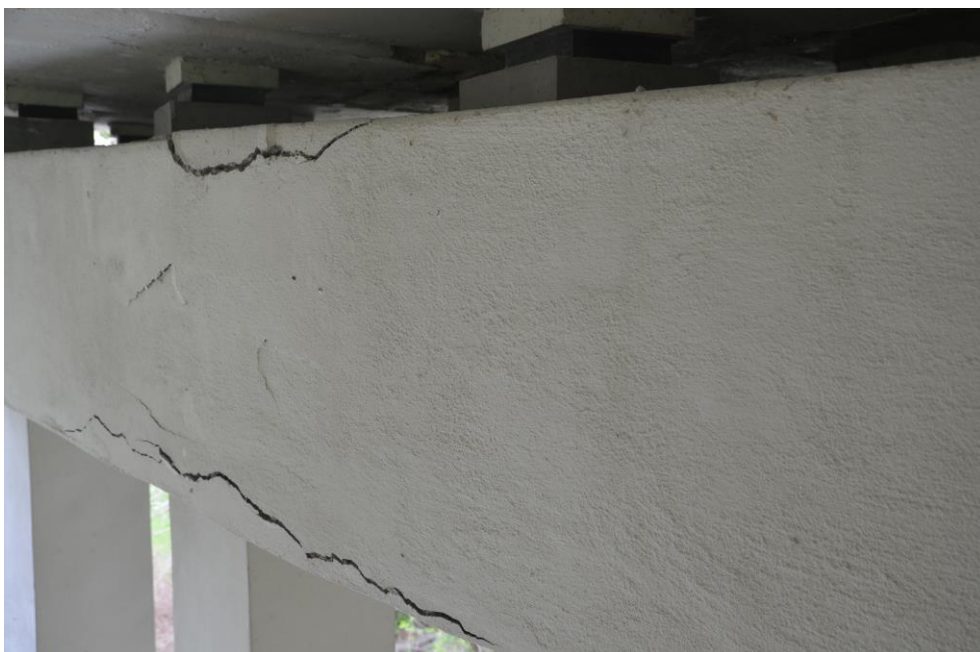
Obr.F32-58 Úložný práh (UP) 2. podpěry, pelhřimovský líc. Neodstraněné odtržení krycích vrstev nad korodující výztuží mezi 7. a 8. sloupem. Pohled proti směru staničení (k Jihlavě) a vzhůru, - výztuž podélná zachvácená korozí již před opravou po r. 1999 nebyla zpřístupněna a v korozi pokračovala pod sanačními vrstvami. Krycí vrstvy musely být uvolněny již tehdy.
