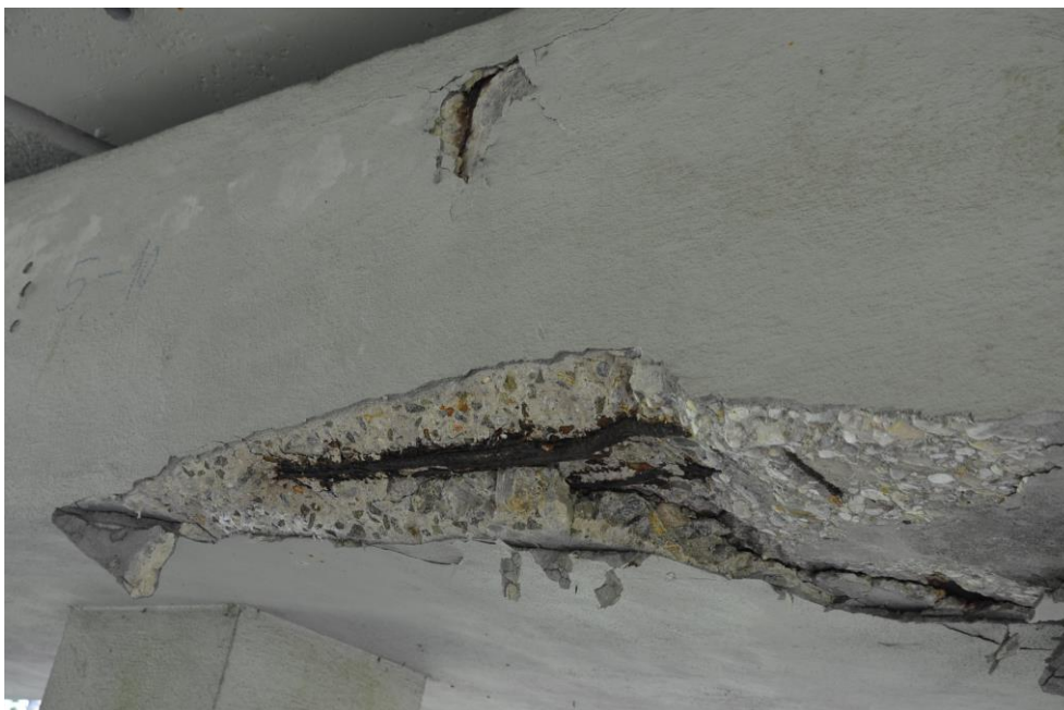
Obr.F32-78 Úložný práh (UP) 5. podpěry pelhřimovský líc. Odtržené krycí vrstvy mezi 9. a 10. ložiskem. Pohled doprava (po vodě), proti směru staničení (k Jihlavě),
