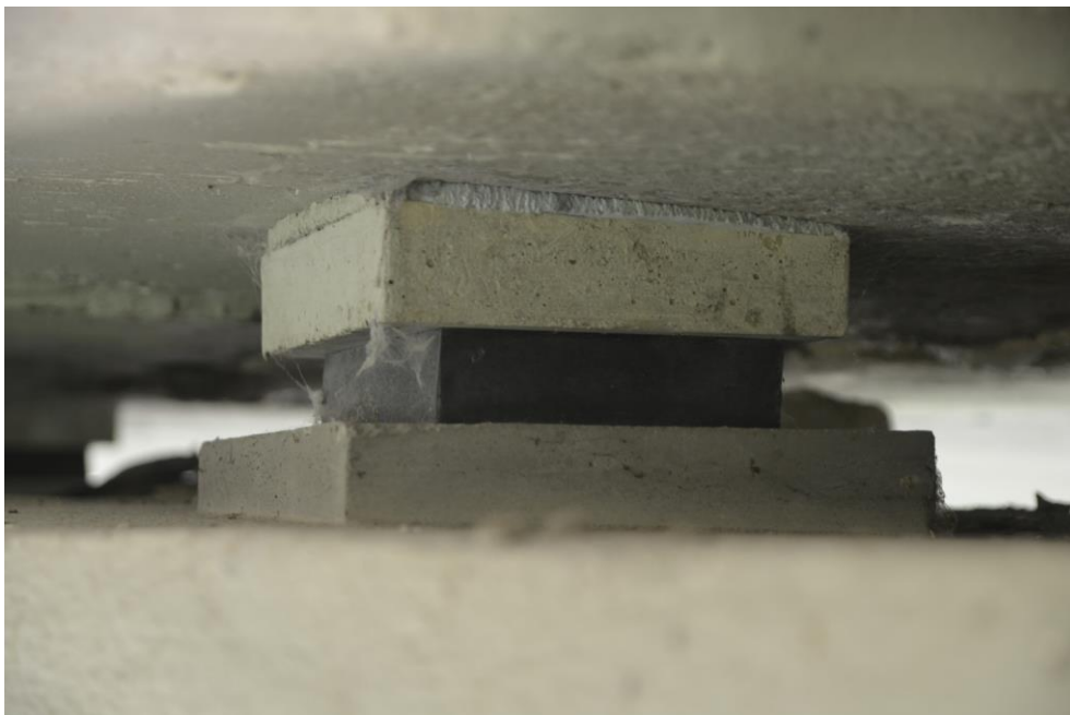
Obr.F32-53 Úložný práh (UP) 2. podpěry, pelhřimovský líc. Ložisko pod 6. nosníkem 2. pole. Pohled doprava (po vodě), proti směru staničení (k Jihlavě) a vzhůru,
