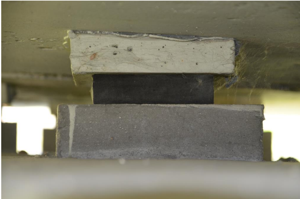
Obr.F32-79 Úložný práh (UP) 5. podpěry, pelhřimovský líc. Ložisko pod 10. nosníkem 5. pole. Pohled doprava (po vodě), proti směru staničení (k Jihlavě) a vzhůru, - ložisko ve vysoké spáře má nad sebou vložený kvádr, pravděpodobně z plastbetonu a tenké podlití, - ložisko je bez závad.
