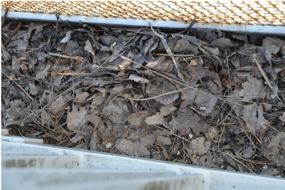
Obr.F32-147 Prostor mezi zábradlím ZS (dole) a levostrannou protidotykovou zábranou (nahore). Pohled zprava doleva a dolů, - prostor je v tloušťce 50 mm znečištěn hlavně listím. To zadržuje vlhkost a přispívá ke korozi jak zábradelních sloupků, tak protidotykové zábrany.
