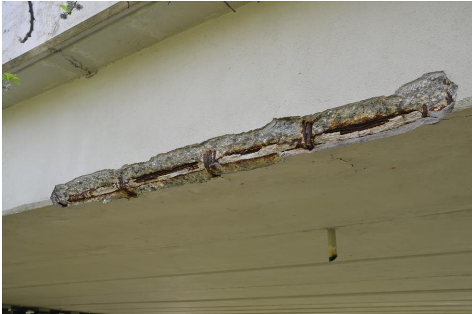
Obr.F32-103 Sonda S 12. Vnější dolní hrana 12.nosníku před první třetinou 2. pole . Pohled proti směru staničení (k Jihlavě) a zprava doleva (proti vodě),
