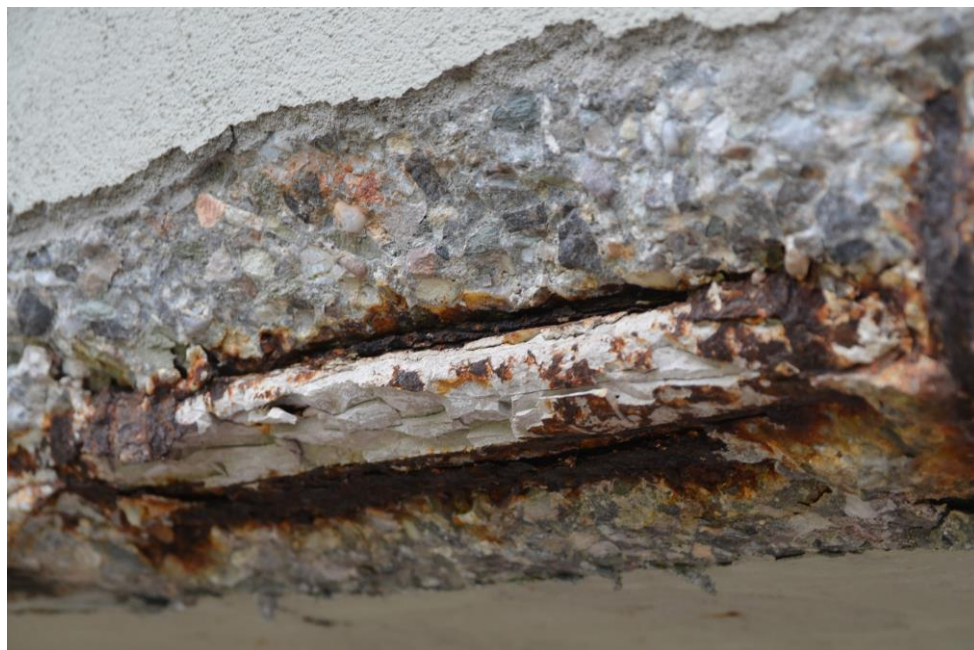
Obr.F32-107 Sonda S 13. Detail levé části odtrhu, obr. F32-106, - v této části je již opadaná zkorodovaná část trubky SANDRIK, ale injektážní malta stále zachovává svoji polohu a kryje prameny předpjatého kabelu. Oslabení, viz obr. F32-108.
