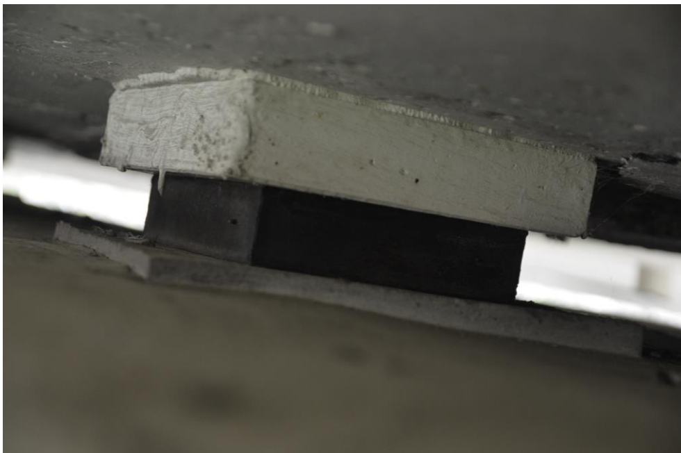
Obr.F32-71 Úložný práh (UP) 5. podpěry, pelhřimovský líc. Ložisko pod 4. nosníkem 5. pole. Pohled doprava (po vodě), proti směru staničení (k Jihlavě) a vzhůru,
