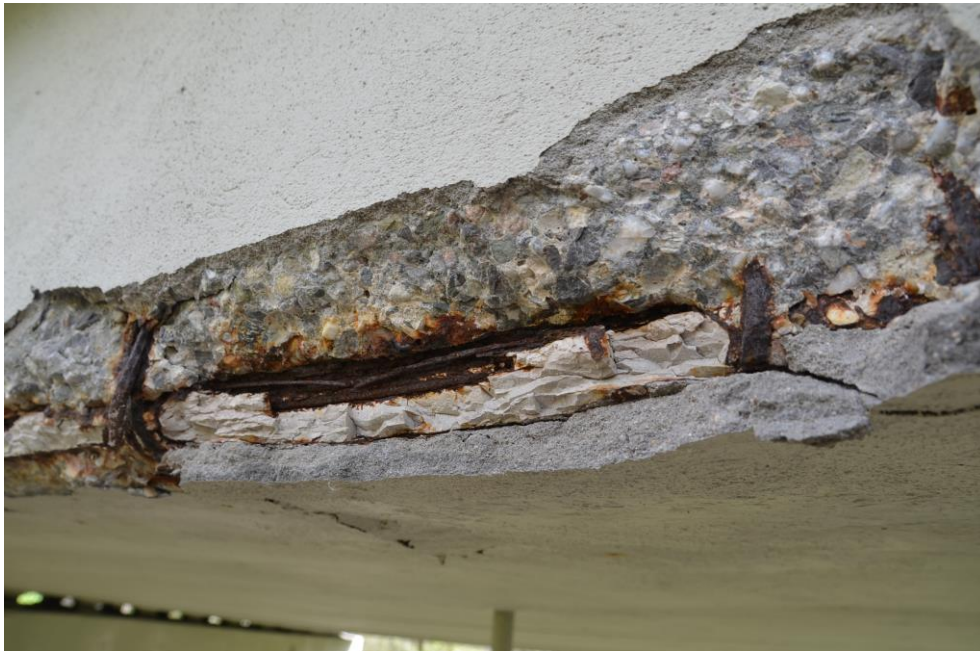
Obr.F32-105 Sonda S 12. Detail pravé části odtrhu, obr. F32-103.
