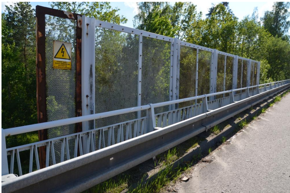
Obr.F32-145 Levostranná protidotyková zábrana ve čtvrtém mostním poli. Pohled zprava doleva (proti vodě) a ve směru staničení (k Pelhřimovu),
