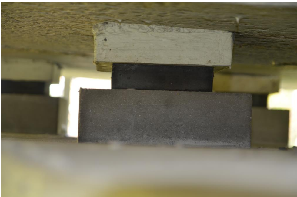
Obr.F32-80 Úložný práh (UP) 5. podpěry, pelhřimovský líc. Ložisko pod 11. nosníkem 5. pole. Pohled doprava (po vodě), proti směru staničení (k Jihlavě) a vzhůru, - ložisko ve vysoké spáře má nad sebou vložený kvádr, pravděpodobně z plastbetonu a tenké podlití, - ložisko je bez závad.
