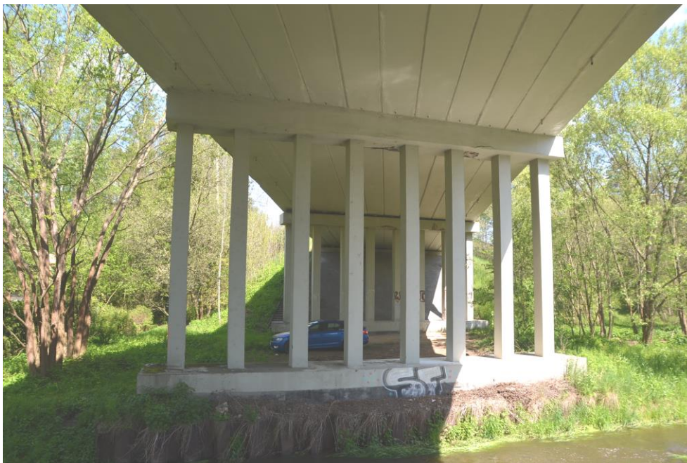
Obr.F32-23 Třetí podpěra. Pohled proti směru staničení, k Jihlavě, - vlevo je směr po vodě, vpravo proti vodě, - do základového pásu je kotveno 8 prefabrikovaných sloupů půdorysu 450x450 mm, - řada z nich je v patě oslabena korozí výztuže po ztrátě pasivačních vlastností betonu krycích vrstev a jejich opadání či uvolnění, - sloupy jsou v patách vyztuženy při jihlavském a pelhřimovském povrchu pěti vložkami betonářské výztuže \varnothing přibližně 20 mm, které zde nejsou nijak výrazně oslabené.
