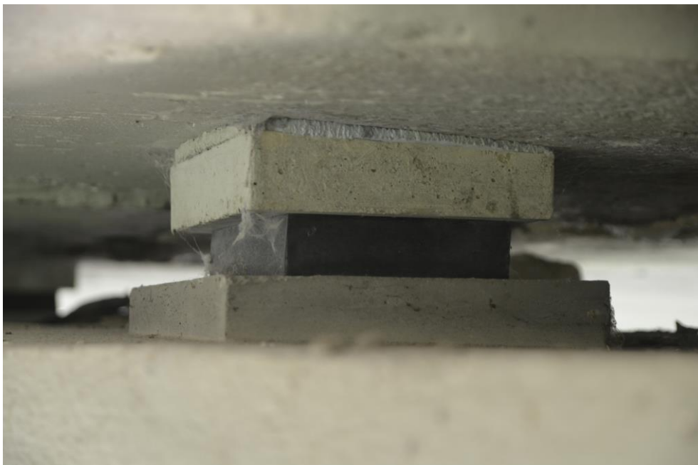
Obr.F32-67 Úložný práh (UP) 5. podpěry, pelhřimovský líc. Ložisko pod 1. nosníkem 5. pole. Pohled doprava (po vodě), proti směru staničení (k Jihlavě) a vzhůru,
