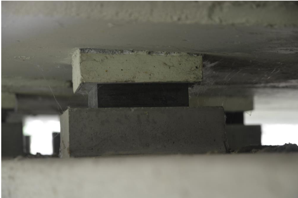
Obr.F32-57 Úložný práh (UP) 2. podpěry, pelhřimovský líc. Ložisko pod 9. nosníkem 2. pole. Pohled doprava (po vodě), proti směru staničení (k Jihlavě) a vzhůru, - ložisko ve vysoké spáře má nad sebou vložený kvádr, pravděpodobně z plastbetonu a tenké podlití, - ložisko je bez závad.
