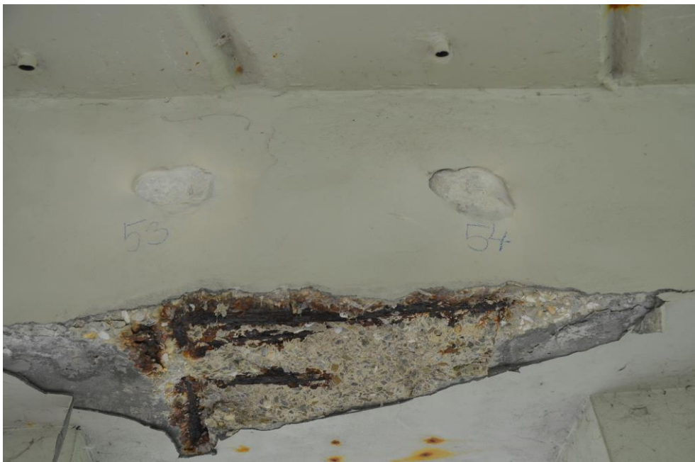
Obr.F32-64 Úložný práh (UP) 3. podpěry, jihlavský líc a podhled Odtržených krycích vrstev mezi 4. a 5. sloupem. Pohled ve směru staničení (k Pelhřimovu) a vzhůru,
