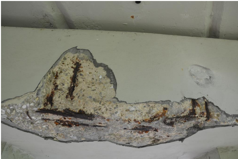
Obr.F32-49 Úložný práh (UP) 2. podpěry, pelhřimovský líc. Odtržení krycích vrstev nad korodující výztuží mezi 2. a 3. sloupem. Pohled proti směru staničení (k Jihlavě) a vzhůru, - výztuž podélná i příčná, zachycená korozi již před opravou po r. 1999 nebyla zpřístupněna, očištěna a v korozi pokračovala pod sanačními vrstvami, - tmavošedé lemování odtrhu je původní „zakouřený“ povrch konstrukce, který nebyl při opravě po r. 1999 řádně otryskán.
