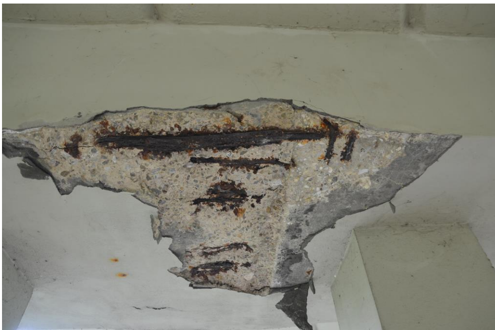
Obr.F32-63 Úložný práh (UP) 3. podpěry, jihlavský líc a podhled Odtržených krycích vrstev mezi 2. a 3. sloupem. Pohled ve směru staničení (k Pelhřimovu) a vzhůru,
