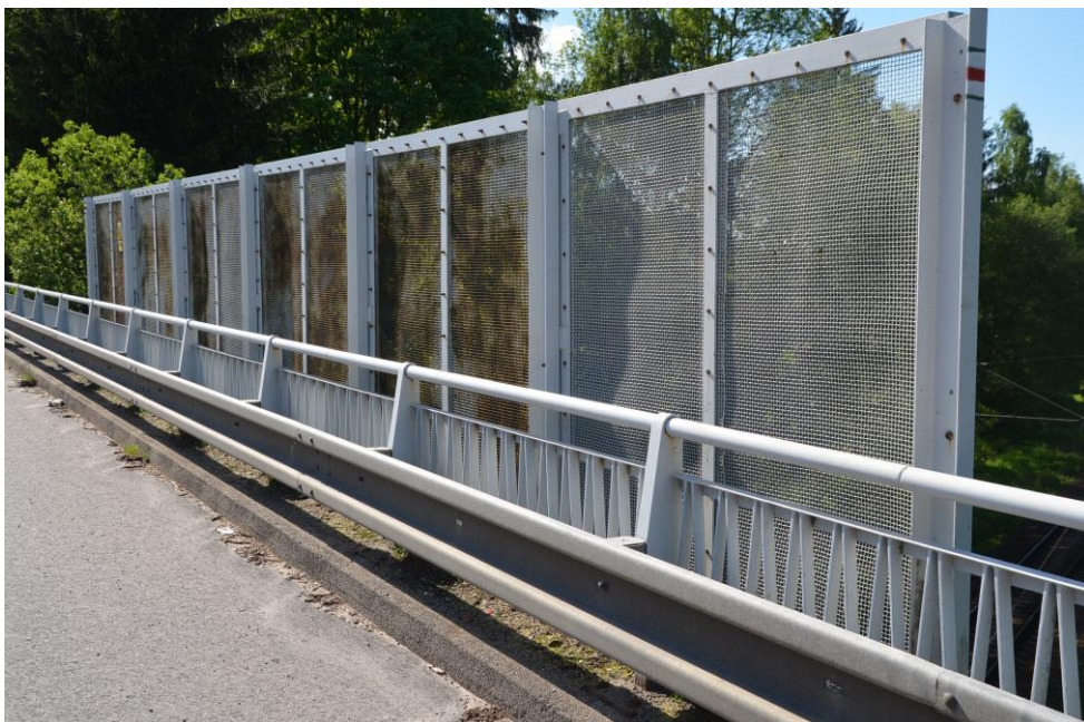
Obr.F32-148 Pravostranná protidotyková zábrana ve čtvrtém mostním poli. Pohled ve směru staničení (k Pelhřimovu) a zleva doprava (po vodě), - protidotykovou zábranu tvoří ocelové pletivo v ocelových rámech, - obojí konzervováno nátěrem. Pletivo koroduje místy v ploše, na rámech jen spojovací materiál, - hůře korodovaný díl (jako na levé straně) se zde nevyskytuje.
